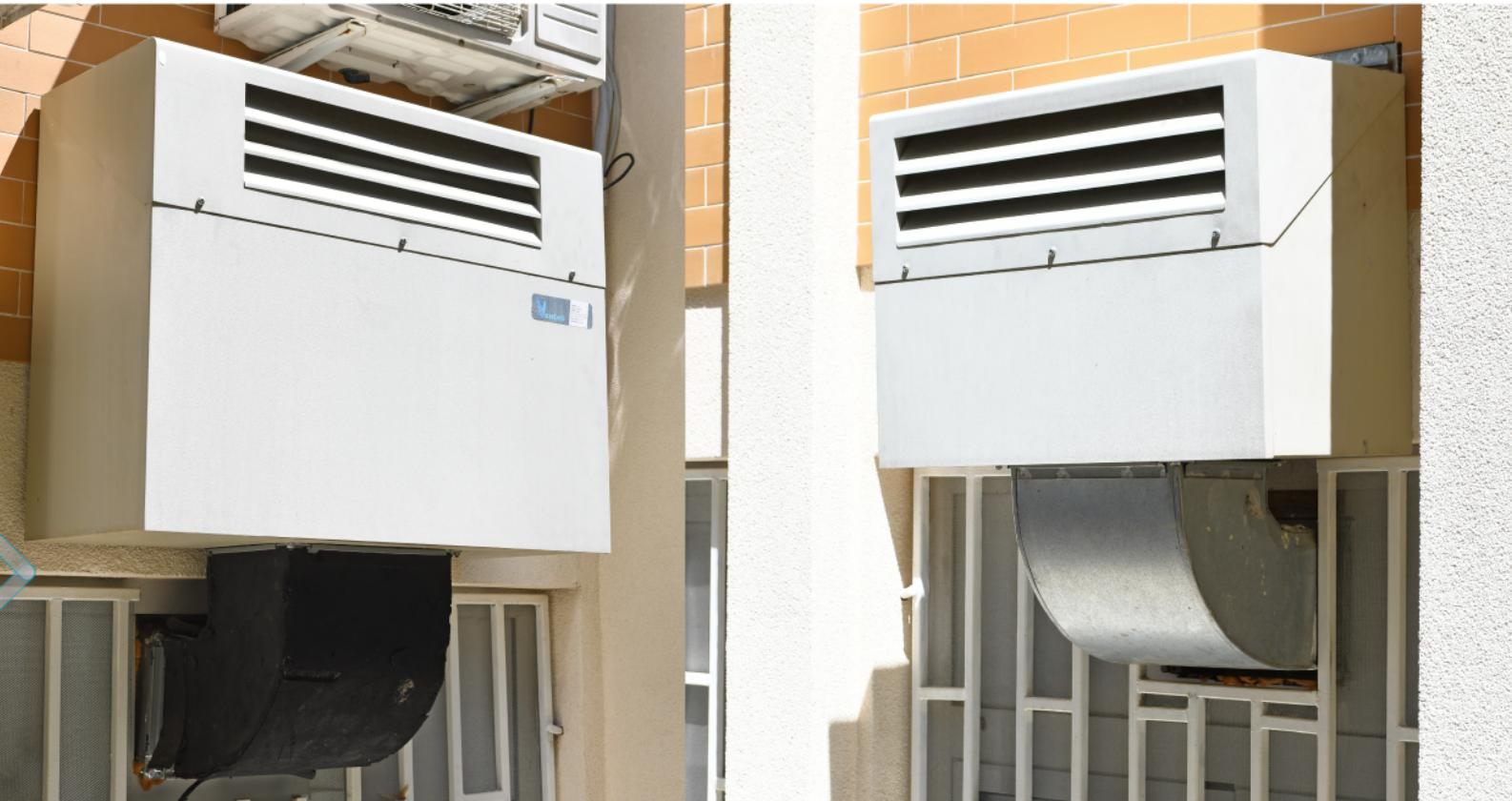
Namenjena za vazdušno grejanje i ventilaciju sa rasponom protoka od 500 do 1500m<sup>3</sup>/h. Komora je predviđena za ugradnju na spoljni zid objekta.
